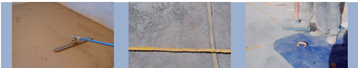
Base capa rodadura y pigmentación. Alisado de la rodadura. Espolvoreo de desmoldeante.
