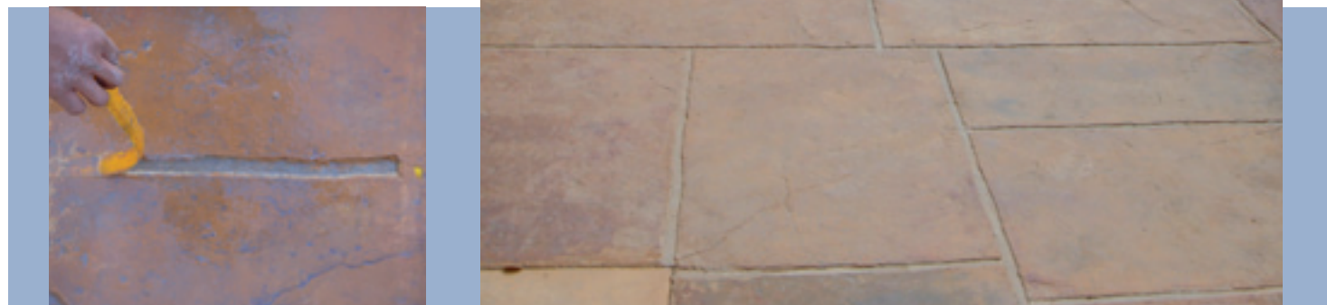
Retirado de tiras y lavado del pavimento.
