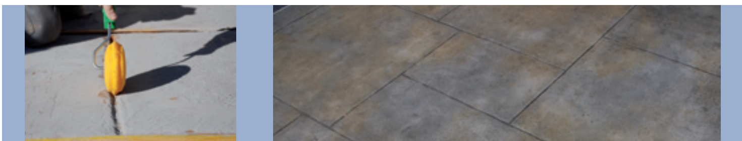
Repaso de juntas con Roler o taco.
