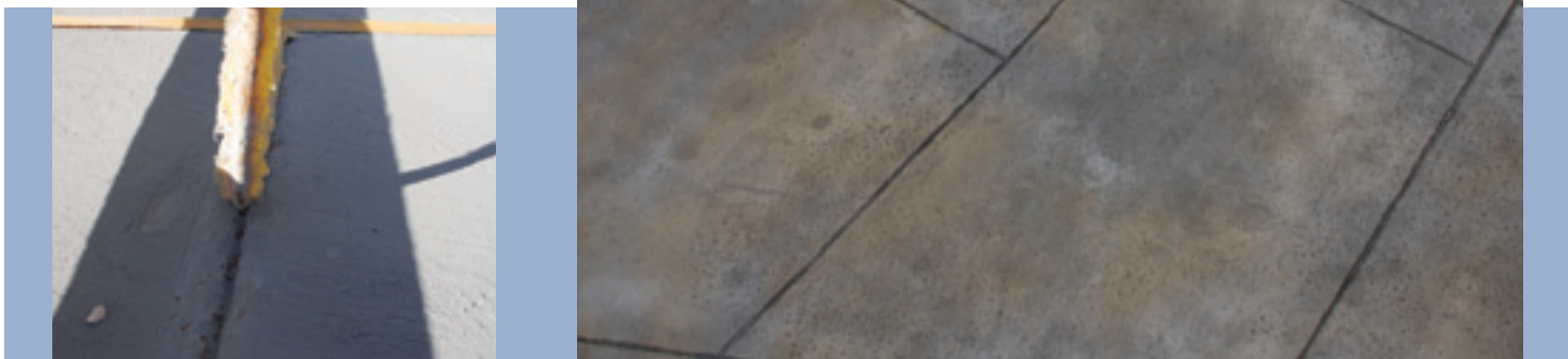
Lavado del pavimento. Pavimento terminado.
